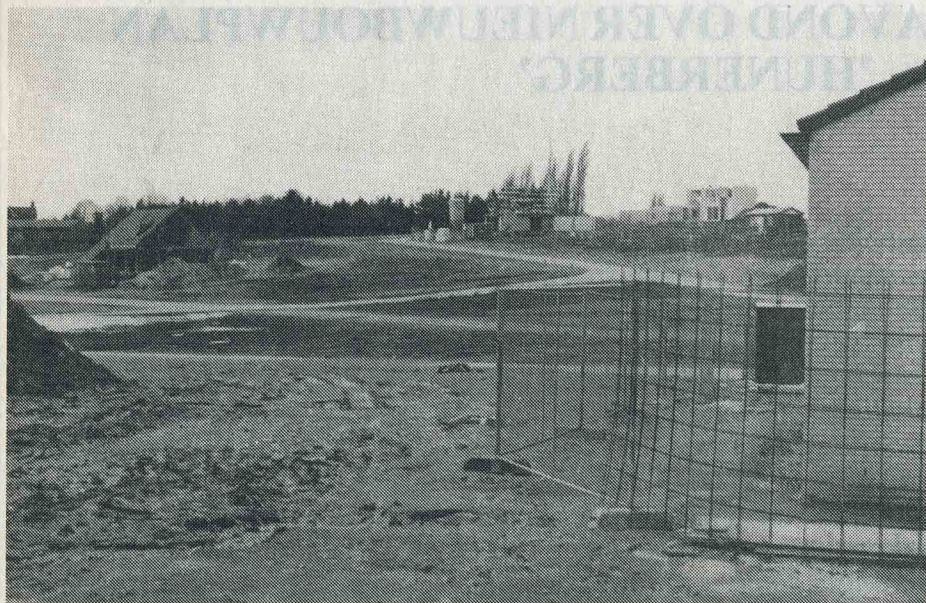
Kruisweg: enkele huizen in aanbouw.
