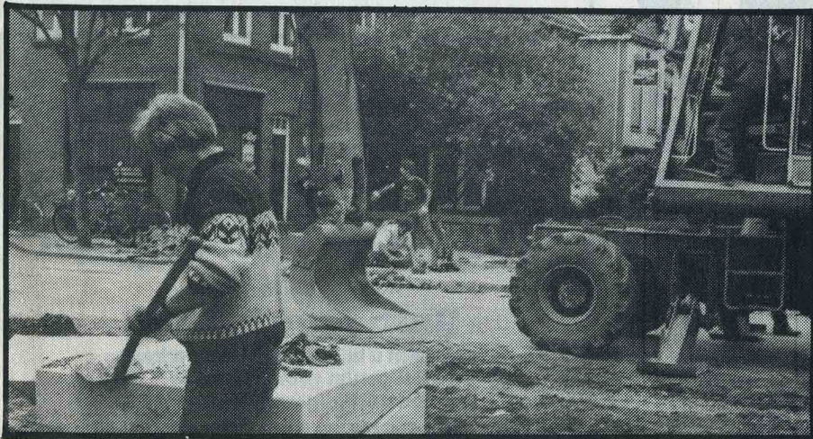
■ Graafwerk door mens en machine
