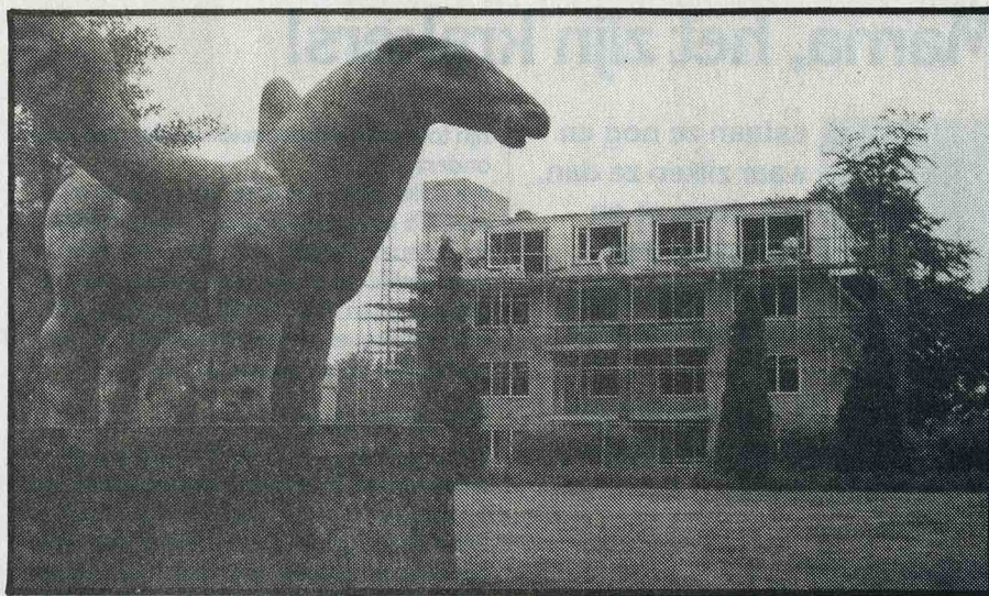
■ Onder toezicht van Pegasus wordt gewerkt aan voltooiing
