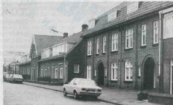
De woningen aan de Eikstraat.
