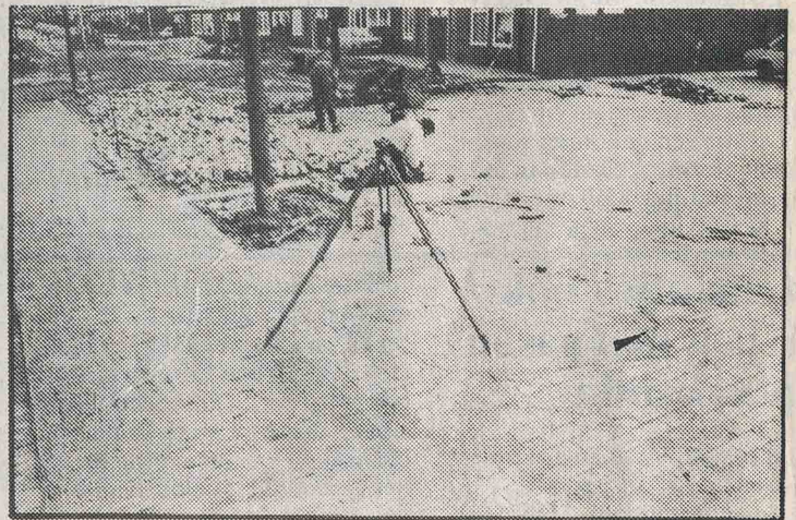
De Sweelinkstraat in aanleg.
