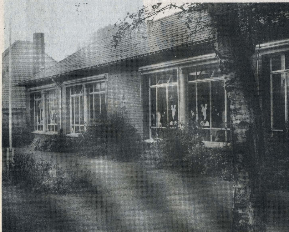
Hard aan vernieuwing toe
