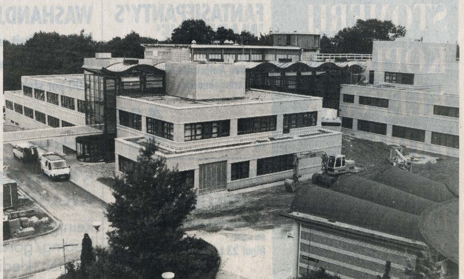
De nieuwbouw krijgt vorm
